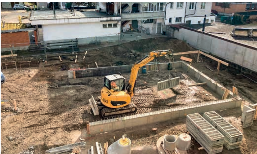
Bauarbeiten am Campus 25+.
