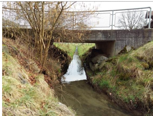
Abb. 14: Brücke über der Oesch
